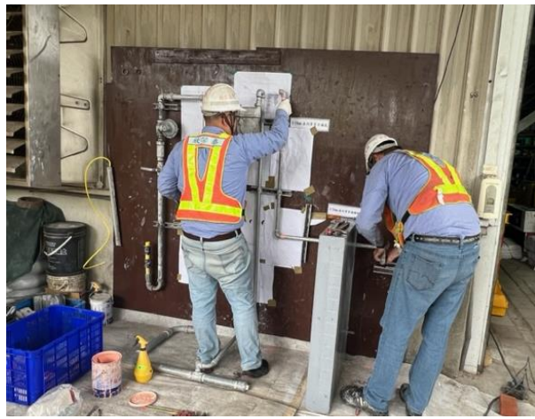
用戶管線檢漏維修訓練
