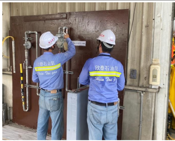
用戶管線檢漏維修訓練
