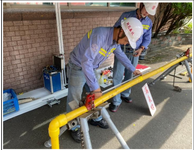
輸氣管線漏氣搶修訓練
