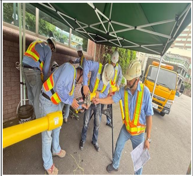
輸氣管線漏氣搶修訓練
